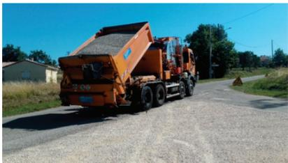
Courant juillet, la Communauté de Communes a réalisé une réfection de nos routes communautaires. Le processus consiste à déposer une très fine couche de bitume chaud et épandre du gravier écrasé par le passage d'un rouleau compresseur. Les trous dans la chaussée ont été comblés auparavant.
